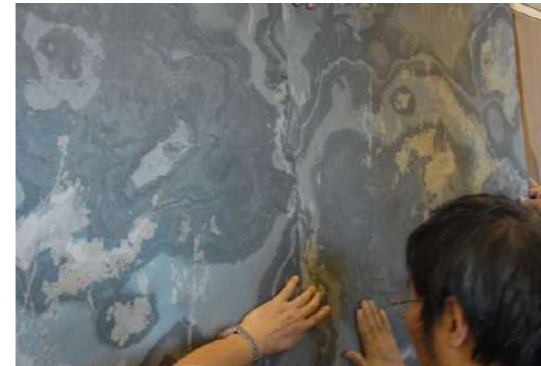
務必讓每片石物緊靠接合，並服貼於牆面，再以手掌壓實或使用糊輪在表面施壓，使接著更緊密。
