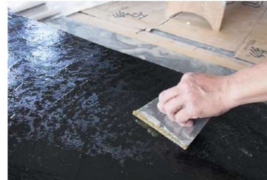
在石物背面使用鋸齒刮刀均勻塗附接著劑。(注意邊角處必須完全著料)
