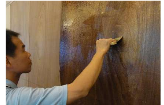
在預計施作的牆面上，使用鋸齒刮刀均勻塗附接著劑，塗上接著劑後約過 10-15 分鐘後，以手指輕觸，若無沾手的情況下即可執行張貼施工。
