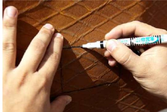
計算損耗：裁切前須先將損耗及插座管線開口計算進去，尺寸依現場為主，圖紙為輔。
