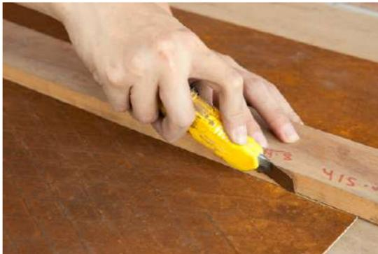
使用美工刀即可輕鬆裁切成所需規格，亦可使用木工切割機台裁切。
